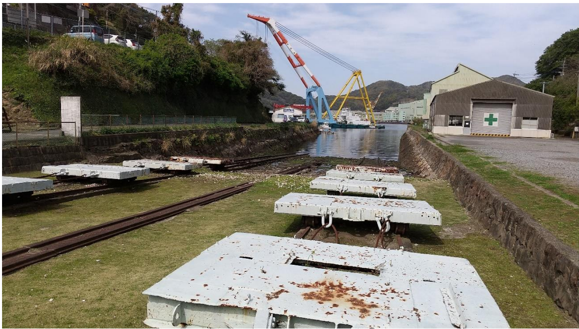
図2 修船場進水部
