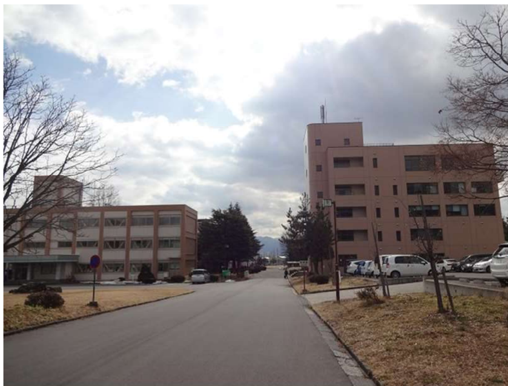
図1 管理・一般科棟（左）および電子情報工学科棟（右）
