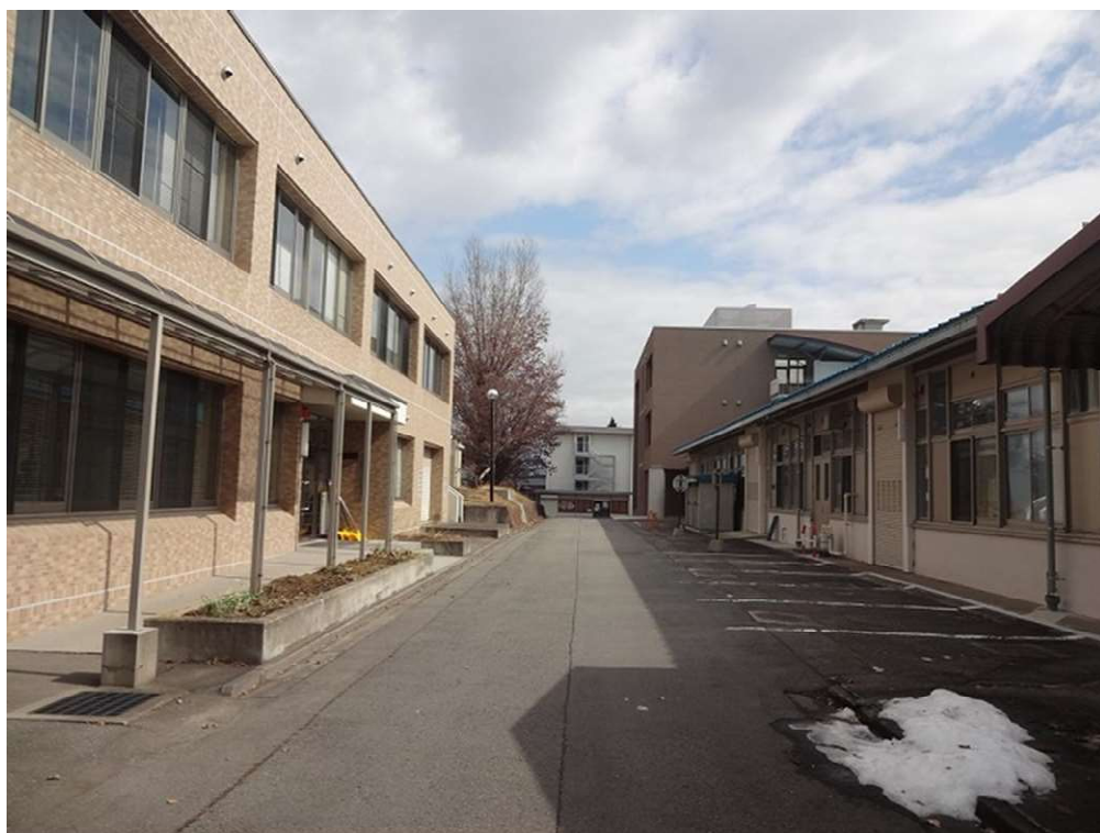
図2 地域共同テクノセンター（左）、学生寮（正面奥）、専攻科棟（正面右奥）および技術教育センター（右）
