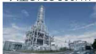
大型GTCC 566MW
