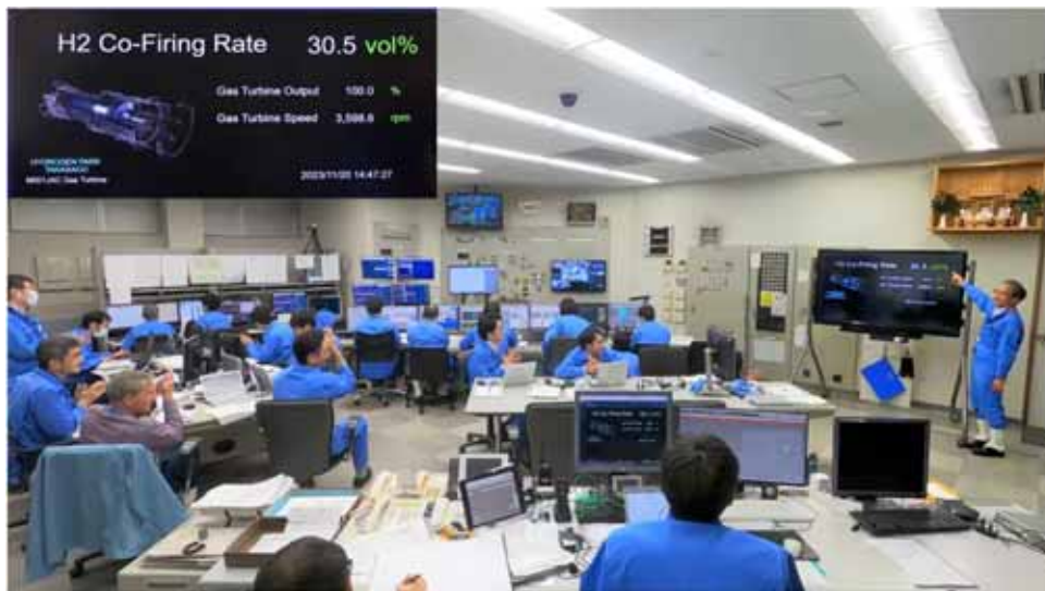
水素燃料30%混焼運転実施中の中央制御室
