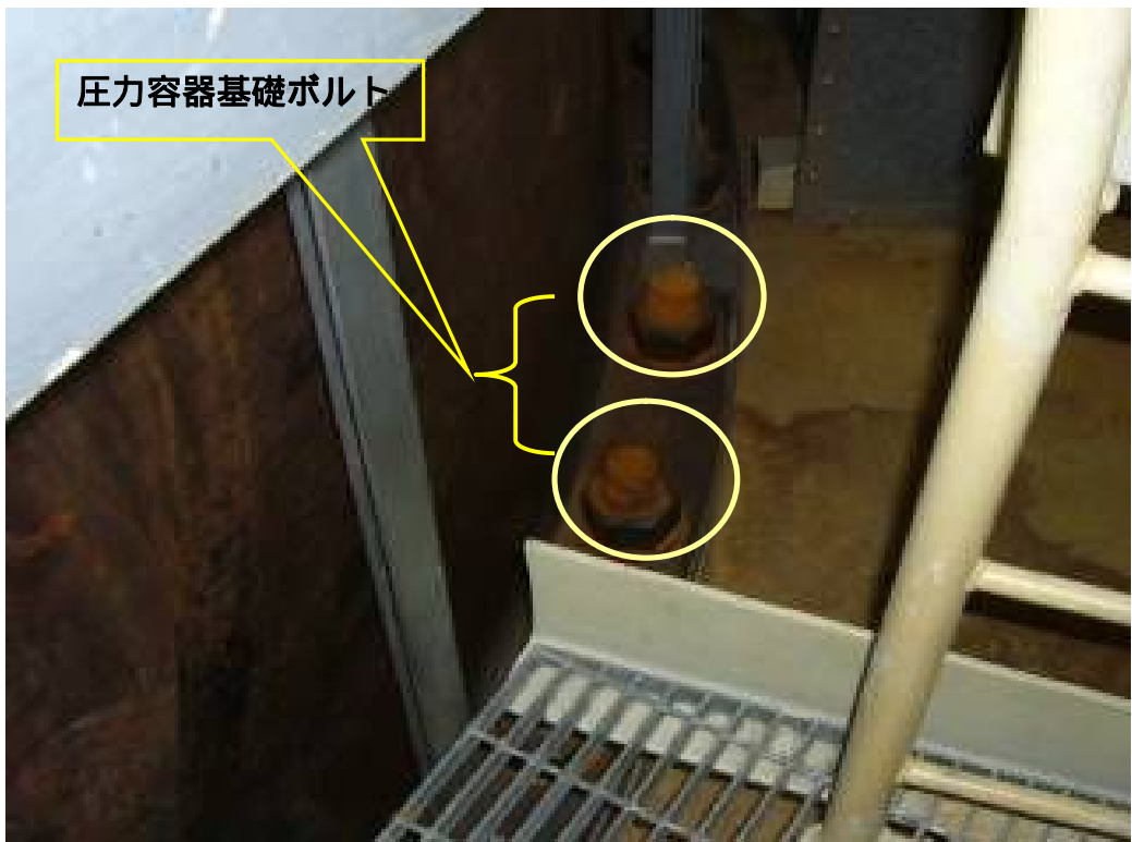
図 2.6 3号機原子炉压力容器基礎ボルト
