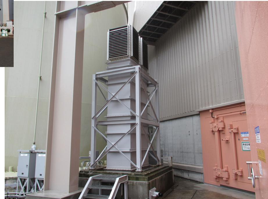
電動補助給水ポンプ室吸気口の嵩上げ
