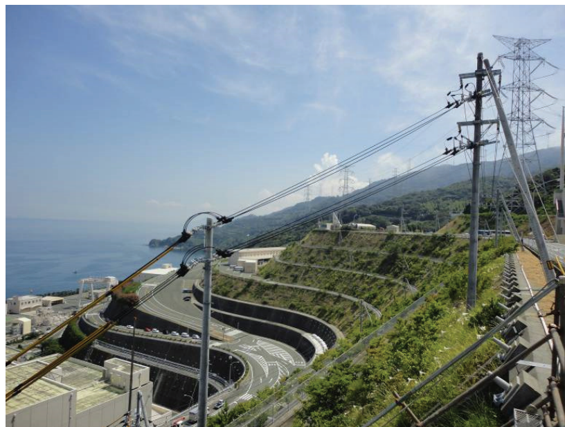
配電線の敷設状況
