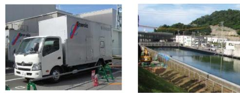
⇒全交流電源が喪失した場合においても、蓄電池(直流電源)が枯渇するまでに高圧発電機車により交流電源を確保するとともに、貯水槽からの送水を可能としたことにより、燃料の重大な損傷に至る事象を回避することが可能となる。
