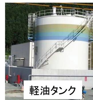
軽油タンク2基(300kL, 560kL)により2台のガスタービン発電機を約1週間連続運転することが可能
