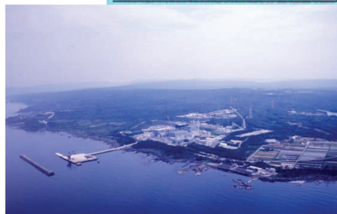
志賀原子力発電所
