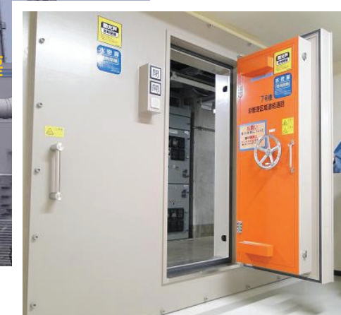
水密扉：重要機器室への浸水を防止(約60箇所)
