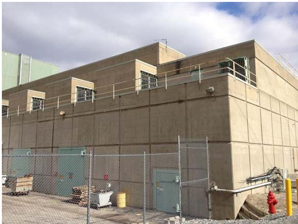
図-2 非常用ディーゼル発電機建屋
