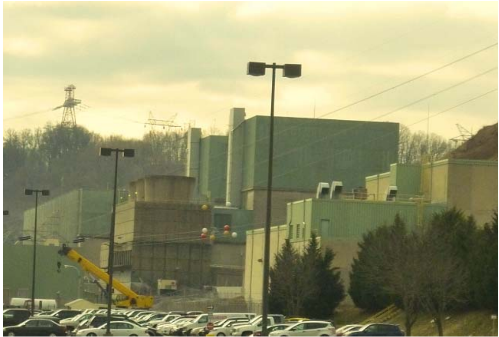
図-1 Peach Bottom 原子力発電所の主要部分の概観 (中央の灰色部分が非常用クーリングタワー)
