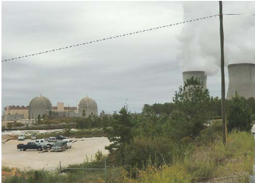
図-1 Vogtle1,2号機の格納容器とクーリングタワー
