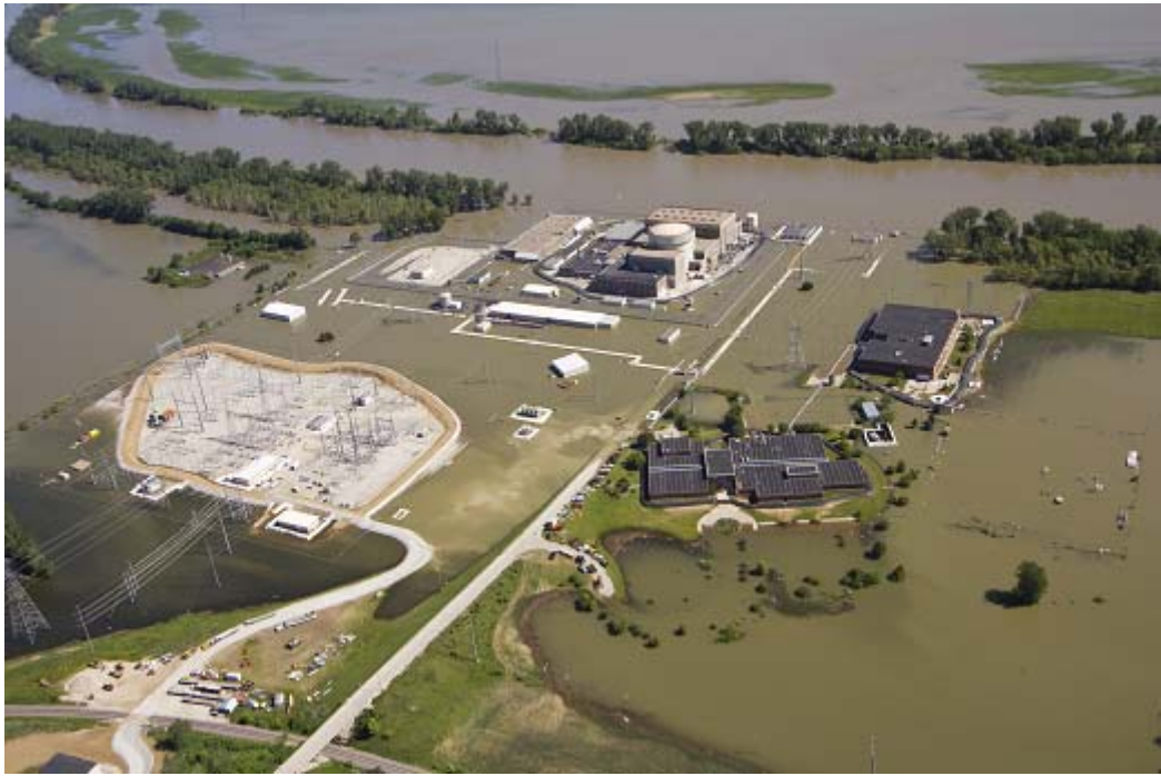
図-7 洪水時の Fort Calhoun 原子力発電所(2)
