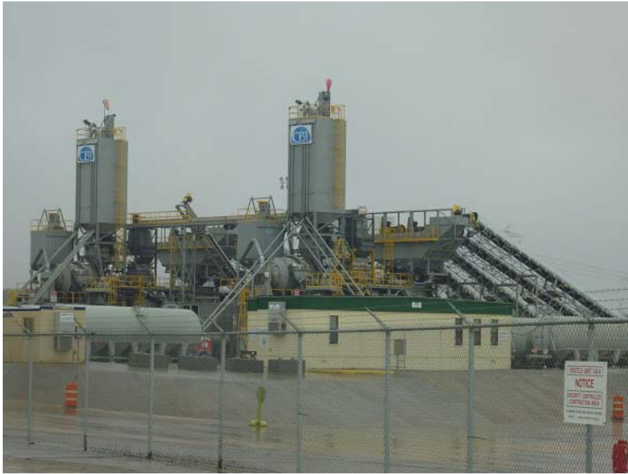
図-7 建設現場のコンクリート工場
