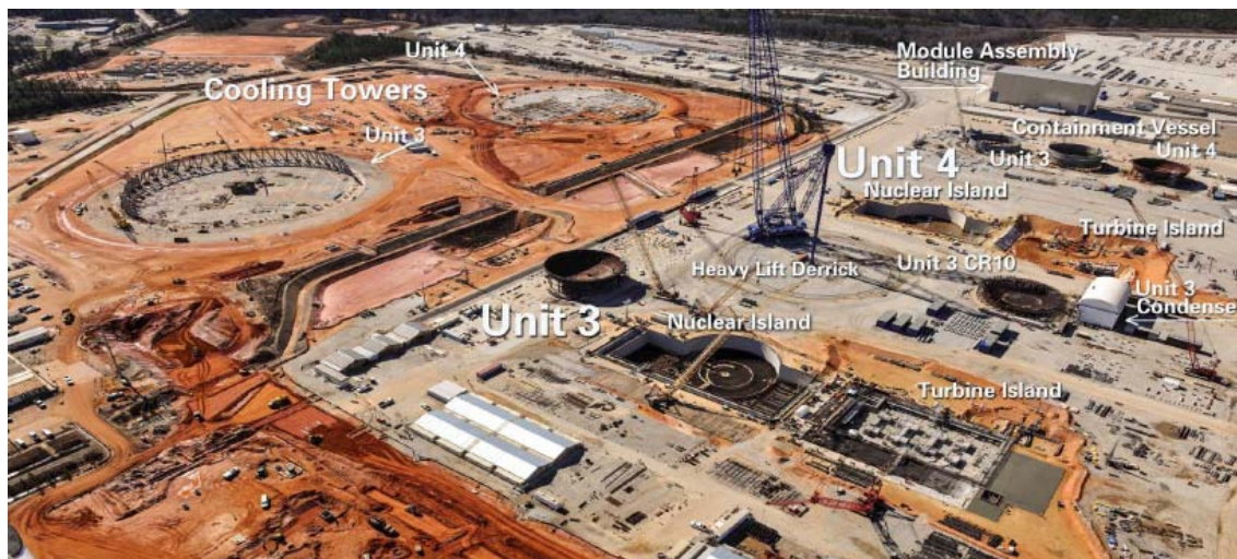
図-2 2013年1月末現在の3,4号機建設現場
