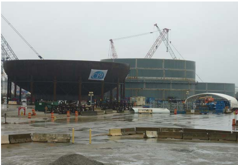
図-4 Vogtle 3,4号機建設現場（格納容器下部ヘッド）
