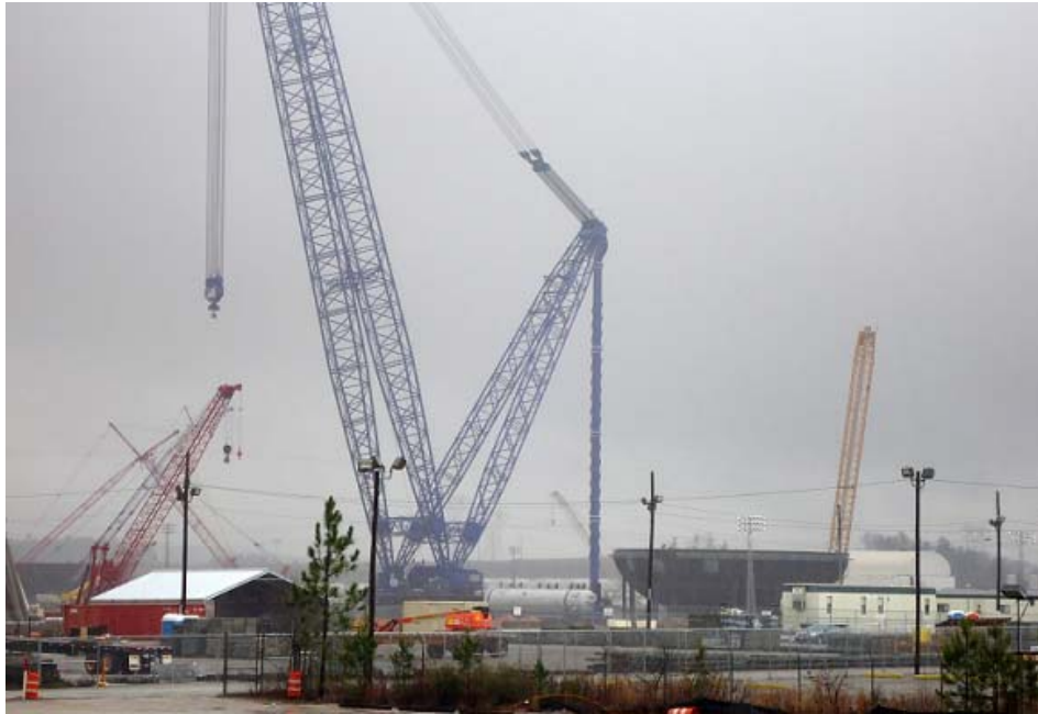
図-5 Vogtle 3,4号機建設現場(格納容器下部ヘッドと世界最大デリッククレーン)
