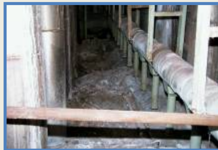
圧力抑制プール2階の溶岩状燃料含有物質の堆積物 (褐色セラミック)
