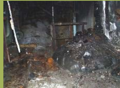
217/2 地点に堆積した溶岩状燃料含有物質 (黒色セラミック)
