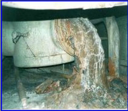
気水分離器210/7地点に堆積した 溶岩状燃料含有物質 (褐色セラミック)
