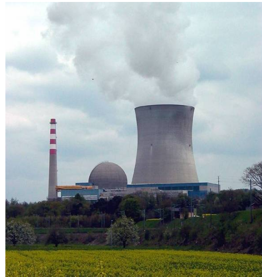
図1 ライプシュタット発電所 (KKL)
