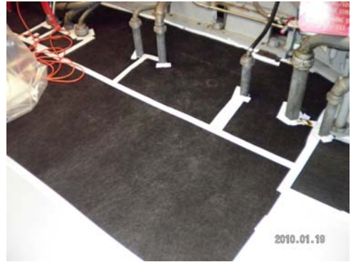
Fig 5.8 DG の OLM の様子④ (油吸着マット)
