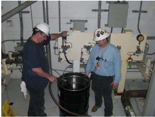
Fig 5.5 DG の OLM の様子① (潤滑油のドレイン)
