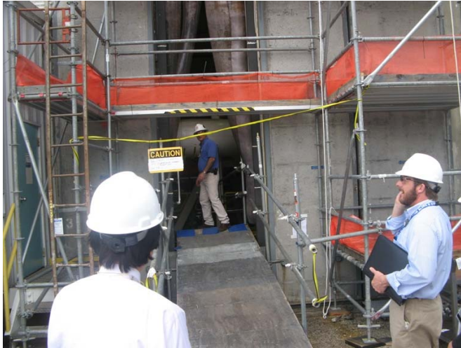
Fig 5.11 OLM 中の DG 建屋入口
