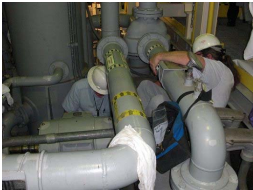
Fig 5.6 DG の OLM の様子②
