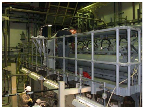
Fig 5.7 DG の OLM の様子③ (シリンダカバーレベルの保守用足場)
