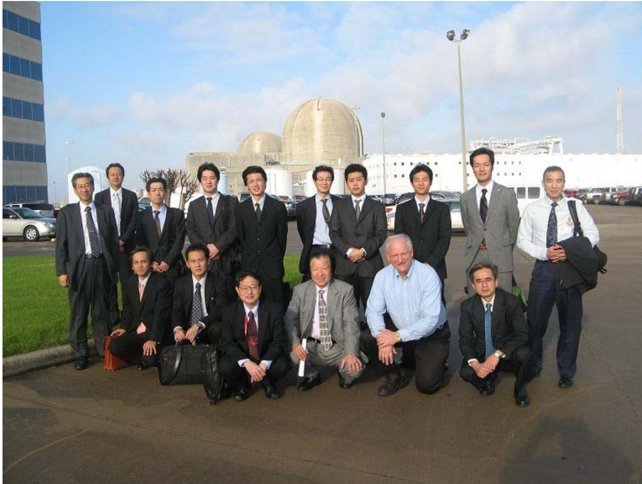
写真-1 South Texas Project 原子力発電所にて
