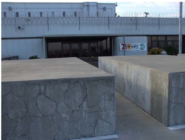
Fig 25 防護区域入口に設置されたコンクリートブロック
