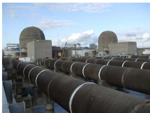
Fig 5.4 循環水配管
