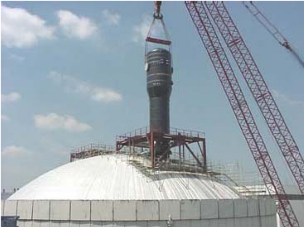
図2 Doel 2 での SG 交換風景
