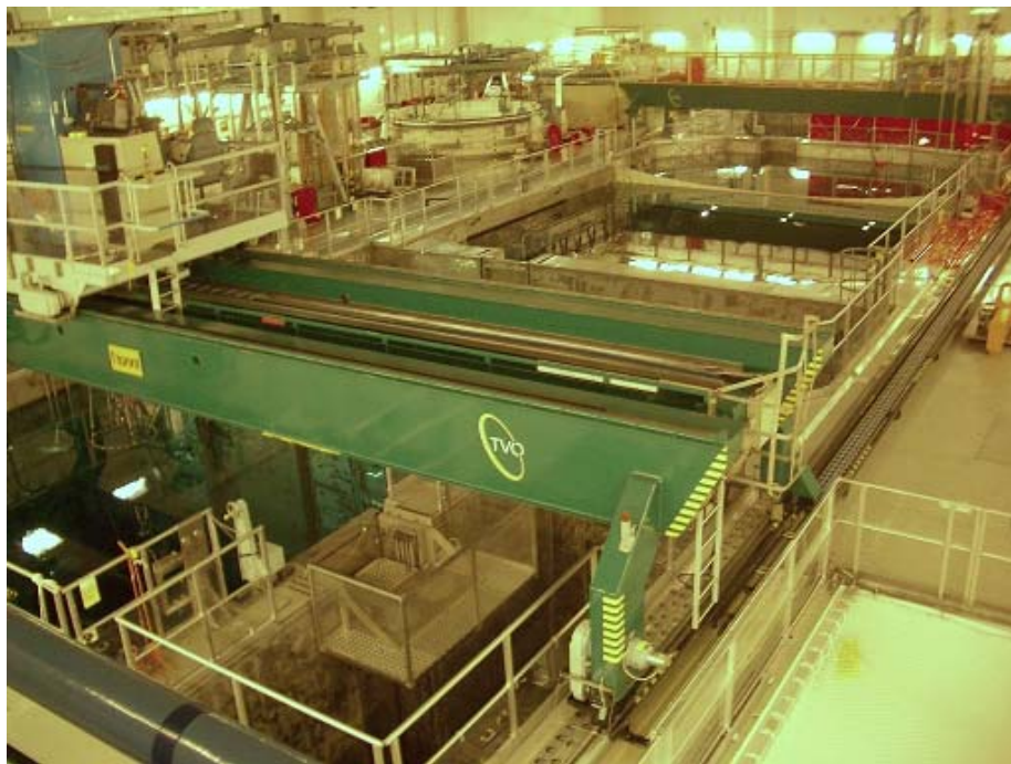
図 I -2 Olkiluoto 原子力発電所 使用済み燃料プール
