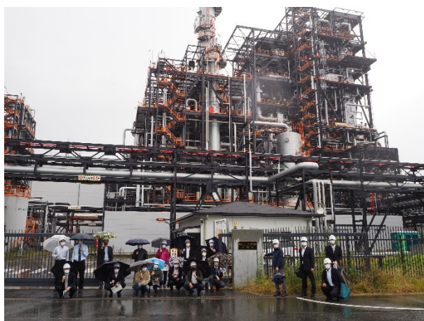
発電所入口にて (ガス化炉・ガス精製設備設備全景)
