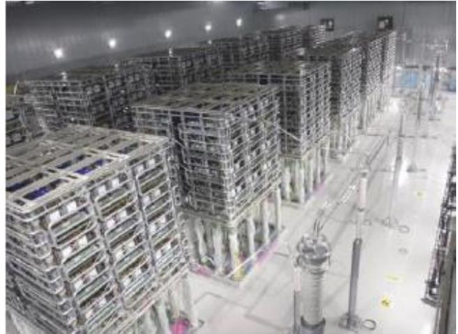
図 3 MMC 変換器バルブ
