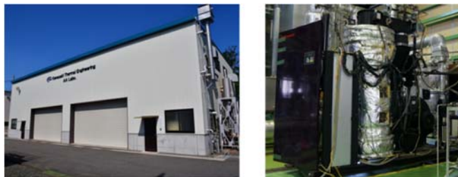
図5 貫流ボイラ実機試験場外観および試験設備
