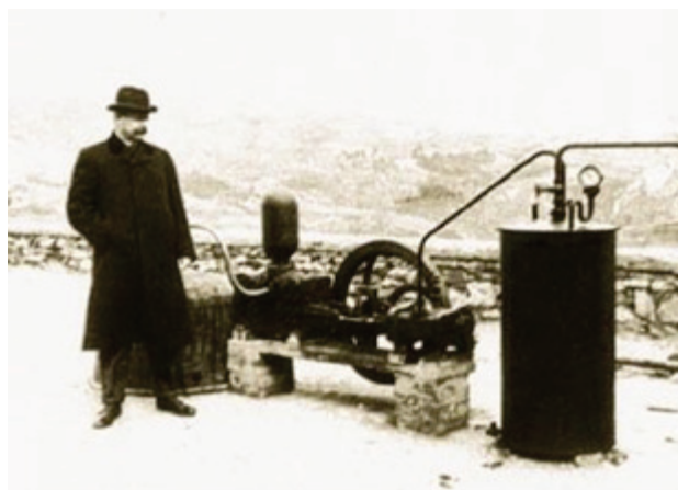
図1 地熱発電実験の様子 (2)
