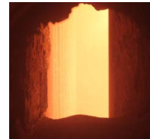
図 5 酸素燃焼時火炎部炉
