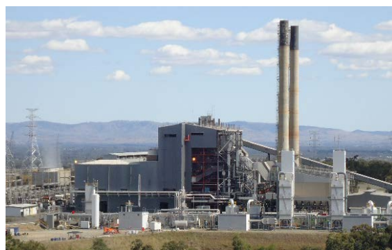
図2 カライド A 発電所全景
