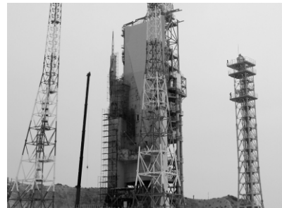
図2：改修中のH-IIAロケット発射台
