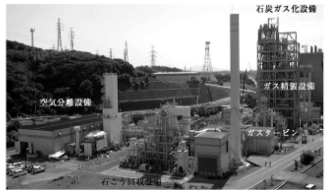
写真1 EAGLEパイロットプラント全景
