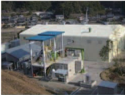
図2 流動層ガス化発電システム 全景
