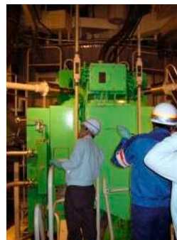
再循環系ポンプのモーターとスナッパなどのサポート
