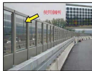
図4 道路遮音壁例(スイス)
