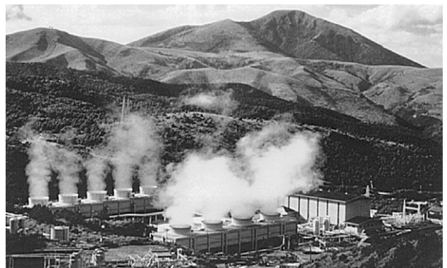
写真1 八丁原発電所
