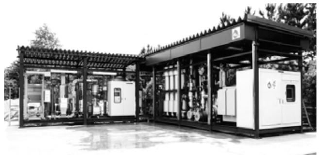
写真1 魔水くんプロト機外観 (処理量1トン/日)
