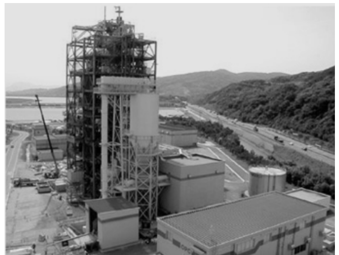
写真1 EAGLEパイロットプラント建設状況
