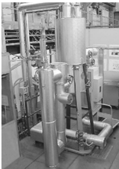
写真1 鉛ビスマス (LBE) 循環装置外観
