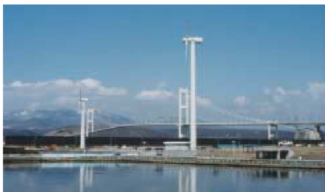
図1. 室蘭祝津風力発電所で稼働中の風力発電装置 MWT-500(左)とMWT-1000(右)
