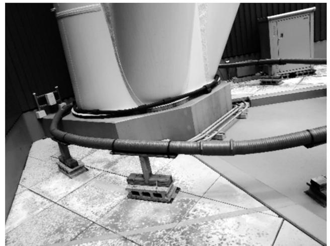
図1 脚の接地部分にあるロゴスキーコイル
