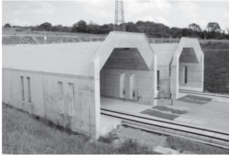
図2 ドイツの70m 緩衝工（建設中、DBST 提供）
