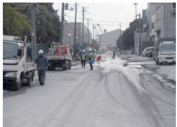
図7 東京湾湾岸の液状化による砂の噴出状況 9)
