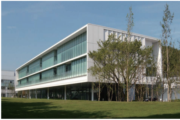
図4 建物の外観写真
