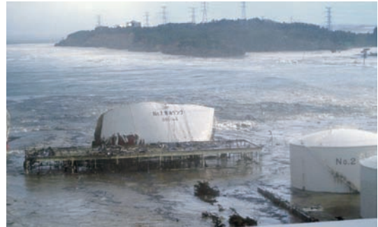
Fig.4 原町火力発電所の津波で押し潰されたタンク 2)
