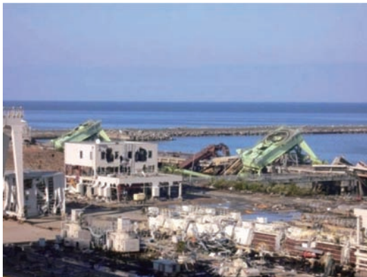
Fig.3 原町火力発電所の津波による設備被害 ( http://www.tohoku-epco.co.jp/emergency/9/1182292_1807.html )
