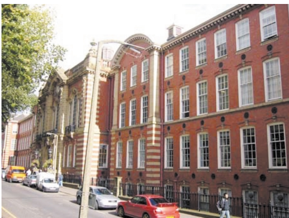
写真1：シェフィールド大学機械工学科棟
