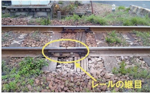
図4 地方交通線のレールの継ぎ目の例
