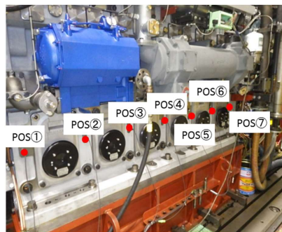
振動センサ設置状況
