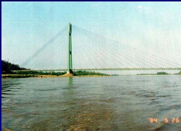
ネパールの奥地に建設 『カルナリ川橋』
