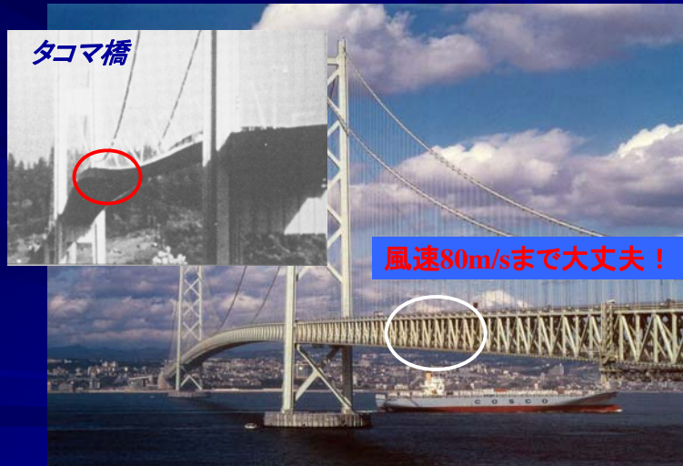
明石海峡大橋(パールブリッジ)
